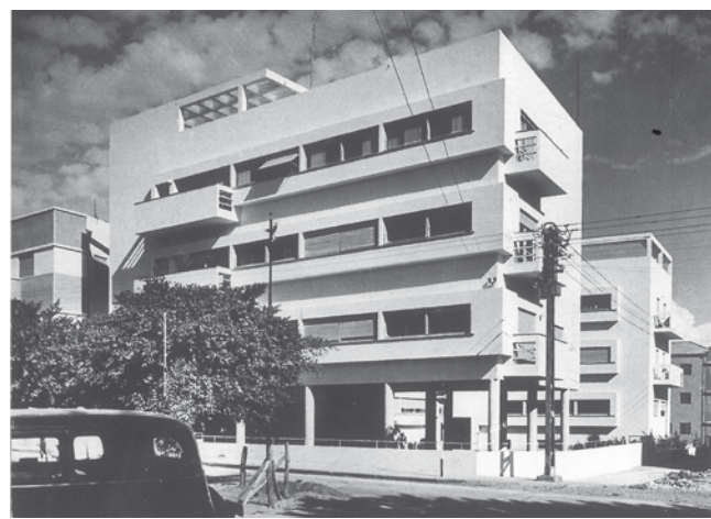
בית אנגל. חלונות סרט, בנייה על עמודים עם גג שטוח וטיח לבן. מתוך חוברת ההכרזה "לגור על החולות, העיר הלבנה של תל-אביב, אתר מורשת עולמית". עיריית תל-אביב-יפו
