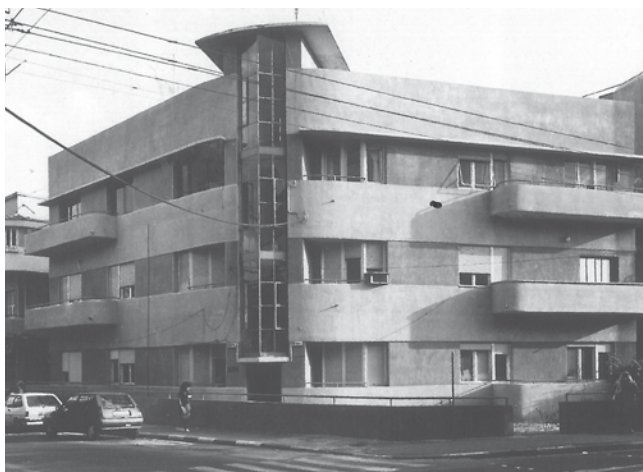
בית רובינסקי וברון. מרפסות, פתחי אוורור, קירות הצללה, חלונות תרמוסטט. מתוך חוברת ההכרזה "לגור על החולות, העיר הלבנה של תל-אביב, אתר מורשת עולמית". עיריית תל-אביב-יפו
