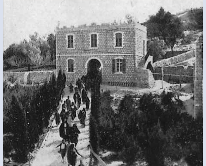
בית השער בראשית המאה ה-20. JMI, נובמבר 1909, עמ' 172. באדיבות הספרייה הלאומית, ירושלים
