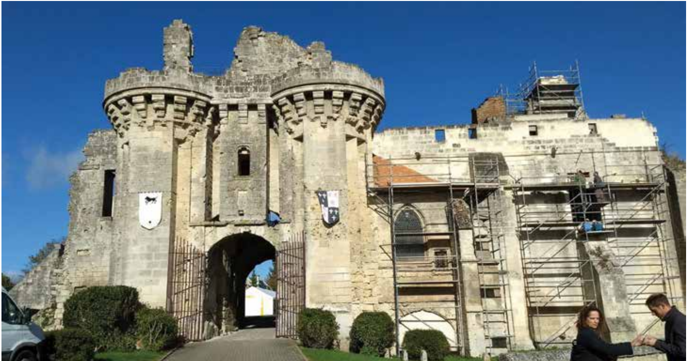
עבודות השימור בטיירה. המשימה - השלמת בניי החלון באבנים מסותות, מסגרת לחלון מסדנת העץ, חלון מסדנת הוויטראיים ופרזול מסדנת הנפחות. צילום: תמר סוכלר
