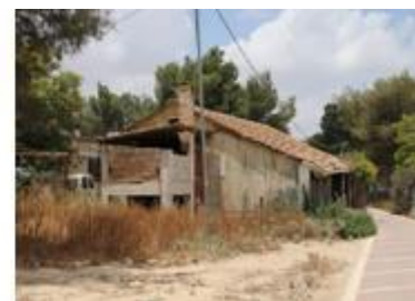
מבנה הצריף לפני השימור והשיקום
