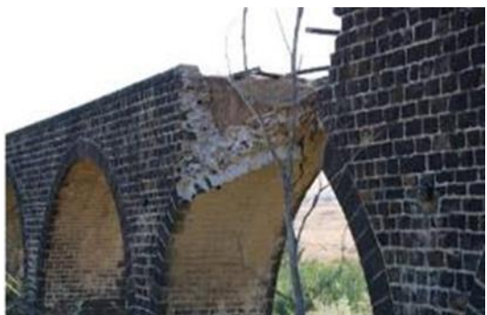
גשר רכבת העמק על הירדן עבודות הצלה וחיזוק הגשר, מסגרת כ-400,000 ₪
