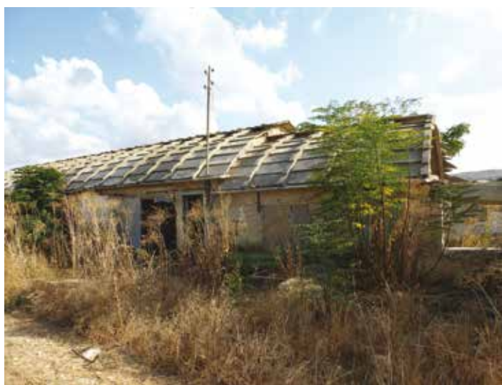
איור 8. רפת בקיבוץ גזר: מבנה טרומי עם גג מקומר הבנוי צלעות בטון מזוין וחיפוי רעפי בטון מיוחדים. צילום: שפר את רונן, הנדסה ושימור מבנים
