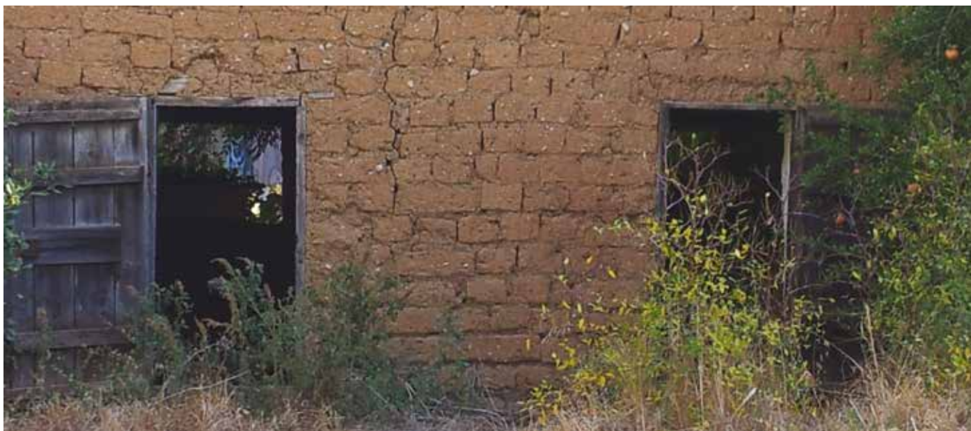
איור 3. מבנה אדמה במושבה יסוד המעלה. צילום: טליה אברמוביץ, 2013
