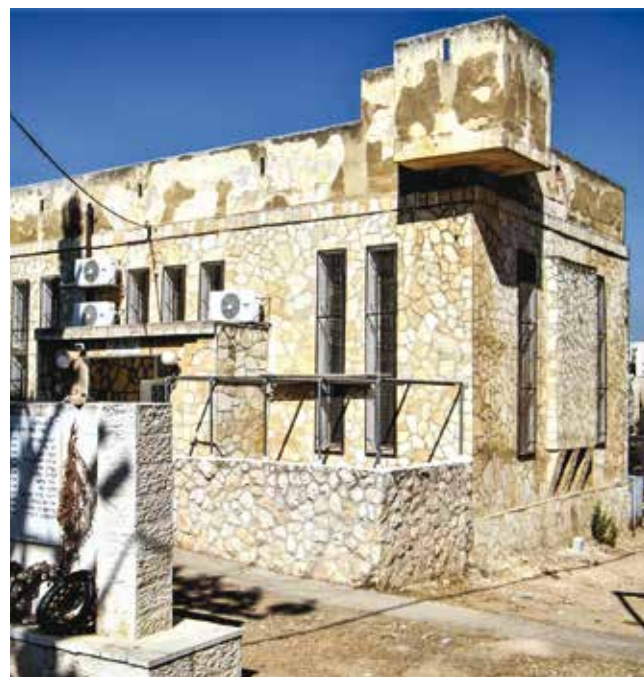
איור 4. מקור חיים, ירושלים. על גג בית הכנסת הוקמה חומת מגן, ובפינות המנוגדות מרפסת לשליטה על קירות המבנה
