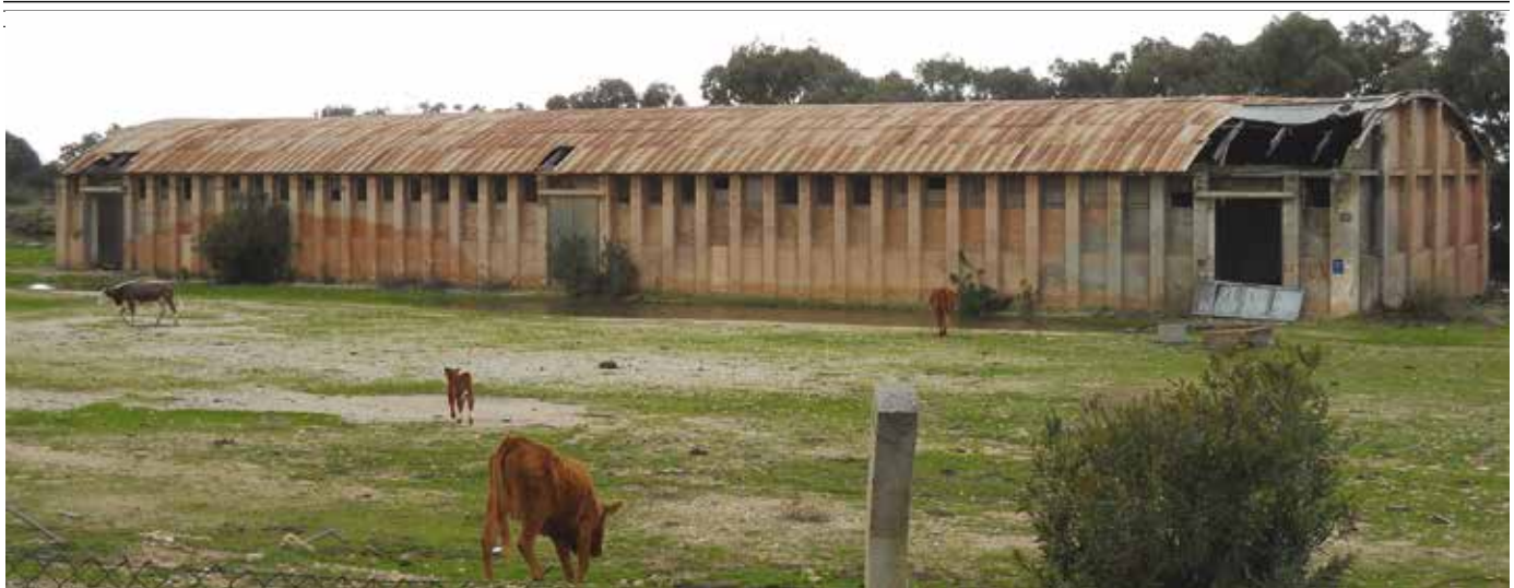
איור 9. עתלית: מבנה טרומי עם גג מקומר מאגדי עץ ומעליהם פח גלי. שרטוט וצילום: שפר את רונן, הנדסה ושימור מבנים
