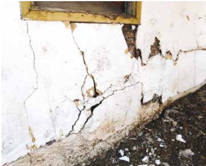
איור 6. פינת בית הבוץ. מבט מכיוון דרום-מזרח לפני חשיפת ה"צוהר אל העבר". איור 7. "שכבת הטיח מתעקמת, נסדקת ומתקלפת". צילום: זאב הררי, 2020
