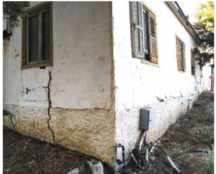
איור 6. פינת בית הבוץ. מבט מכיוון דרום-מזרח לפני חשיפת ה"צוהר אל העבר". איור 7. "שכבת הטיח מתעקמת, נסדקת ומתקלפת". צילום: זאב הררי, 2020
