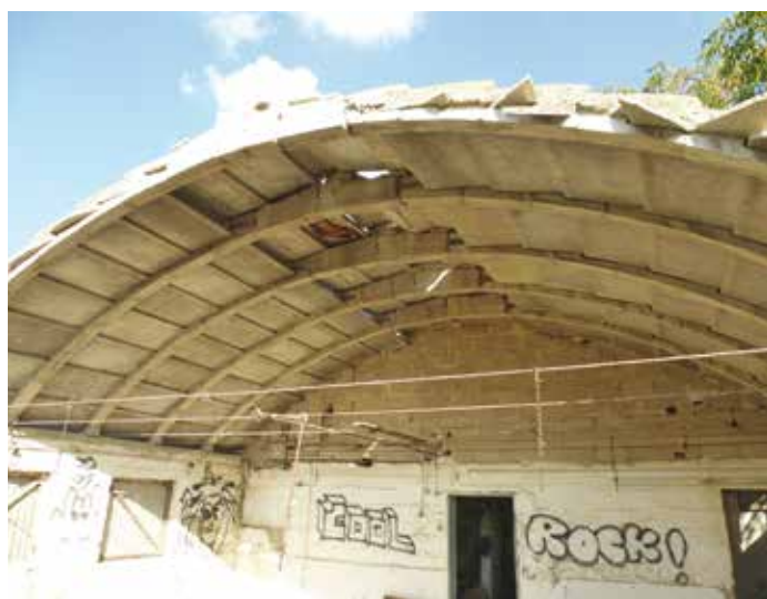
איור 8. רפת בקיבוץ גזר: מבנה טרומי עם גג מקומר הבנוי צלעות בטון מזוין וחיפוי רעפי בטון מיוחדים. צילום: שפר את רונן, הנדסה ושימור מבנים
