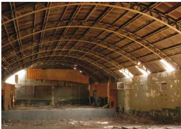
איור 10. ראש העין: בית קולנוע היסטורי, בנוי מלבני סליקט, מחופה קמרון הבנוי אגדי פח מכופף ומעליהם חיפוי פח גלי. למעלה ומימין - שרטוט וצילום: שפר את רונן, הנדסה ושימור מבנים; משמאל - צילום: אורי פדן אדריכלים
