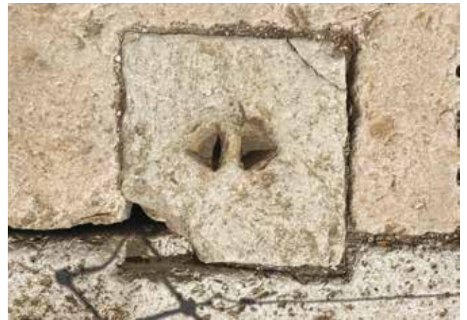
איור 4. מכסה בור ניקוז מאבן גיר ברחוב הראשי בירושלים משלהי הבית השני (המאה הראשונה לספירה). צילום: שי פרקש
