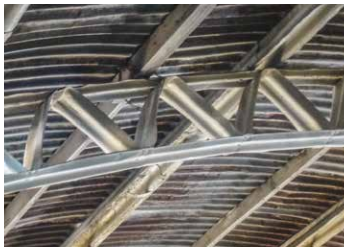
איור 10. ראש העין: בית קולנוע היסטורי, בנוי מלבני סליקט, מחופה קמרון הבנוי אגדי פח מכופף ומעליהם חיפוי פח גלי. למעלה ומימין - שרטוט וצילום: שפר את רונן, הנדסה ושימור מבנים; משמאל - צילום: אורי פדן אדריכלים
