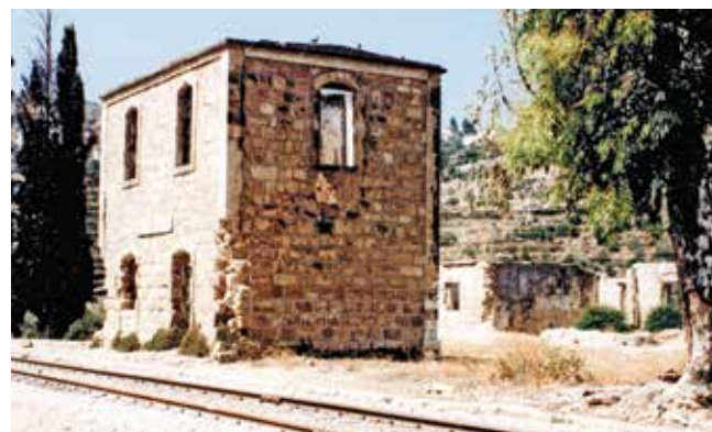
איור 4. תחנת ביתר הנטושה. צילום: רון שפיר, 1999
