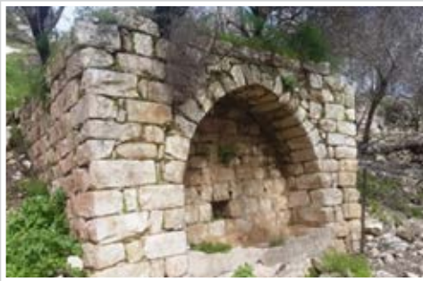
איור 8: חזית מבנה המים, ושלושה פתחי צינורות והברזים. בגב מבנה שוקת המים מצוי מיכל מטויה לתוכו נכנס צינור שמילא אותו והזין זרימת מים דרך שלושה פתחי ברזים בחזית שעדיין קיימים
