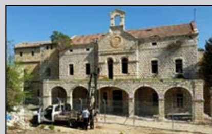
איור 5: לפני פירוק המרפסת
