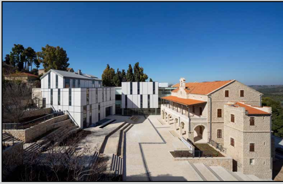
חלקו הדרום - מערבי של בית בוסל לקראת סיום עבודות הבינוי, הפיתוח והשימור צילום: מיקלה ברסטו
