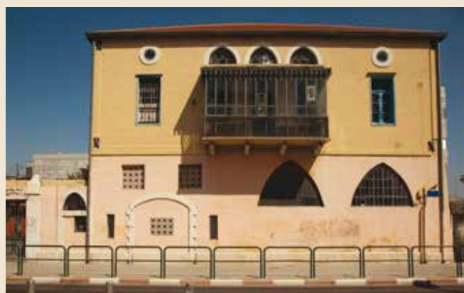
איור 7. בית עלי ביבי, רחוב עזה 13 - בית ספר סוקולוב לאור לשעבר. מיכל בר-אור, 2011
