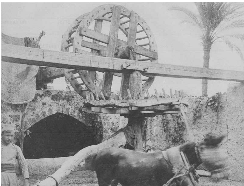
איורים 6א, 6ב, תמורות בקורה הראשית: למעלה - קורת עץ טבעי מעוקלת. מקור: אוסף שמוליק תגר. למטה - קורה ראשית וציר עשויים קורות עץ מנוסרות. מקור: אוסף מטסון, ספריית הקונגרס, LC 0006
