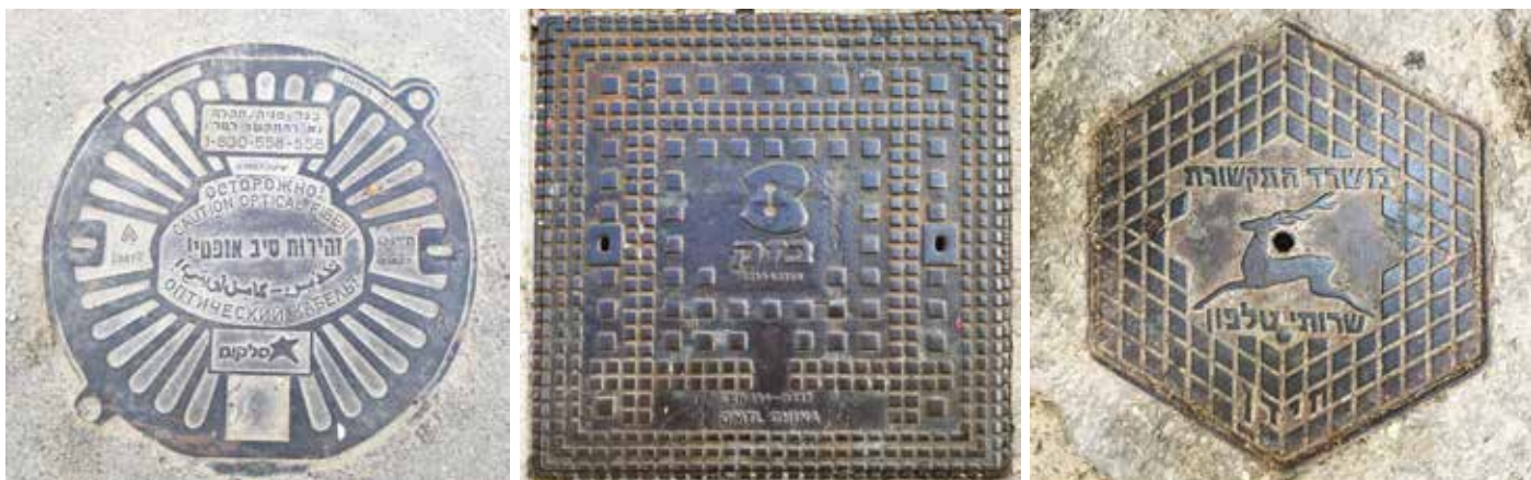
איור 17. מכסי בורות לתקשורת ואינטרנט. צילום: שי פרקש
