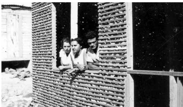
איור 3. תהליך הבנייה של בתי בוץ בקיבוץ מרחביה, תחילת שנות השלושים. מקור: ארכיון קיבוץ מרחביה ו"ביתמונה"
