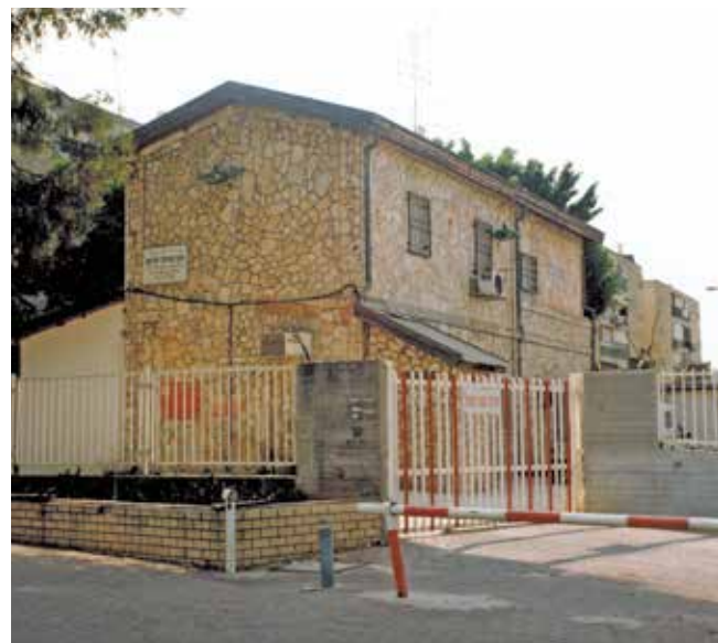
איור 2. מבנה תחנת לוד כיום. צילום: רון שפיר
