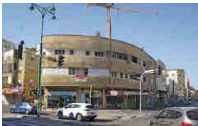
איור 8. לב חדרה: מעבר ממושבה לעיר, "מבנה עירוני" מיוחד המגדיר את רוח המקום והתקופה - לשימור מרקמי ואדריכלי. צילום: דרור סולר
