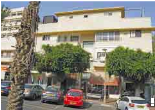
איור 7. לב חדרה: מבנה אופייני לרחוב ראשי, שילוב של מסחר ומגורים, בעל ערך אדריכלי וערך עירוני גבוהים - לשימור מרקמי ובפני עצמו. צילום: דרור סולר
