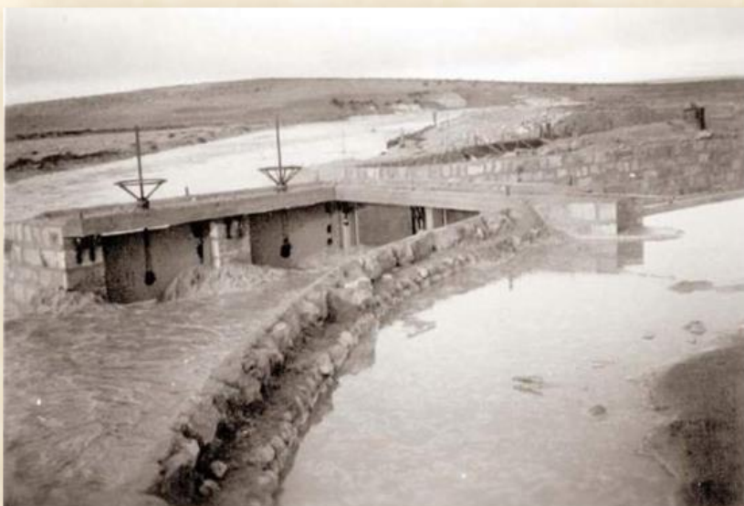
בפיקוח המהנדס קובלנוב הוקמו ליד הקיבוץ מאגר ומערכת לתפיסת מים. שטפון גדול שמתרחש אותה שנה הרס את מתקני התפיסה ופוּרַץ את סוללת המאגר: ארכיון רביבים
