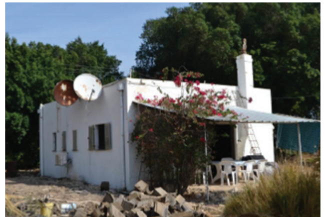
חזית דרומית והמרפסת המקורה (כיום קירווי לוחות איסכורית כתחליף למצללת עץ טבעי)
