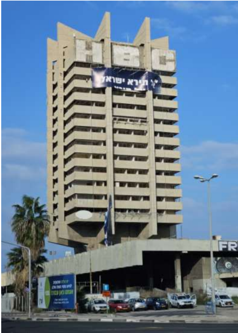
דצמבר 2023: המבנה מוזנח, נצפות התפוררויות בטון בחזיתות המבנה. מקור: אוסף הועצה לשימור
