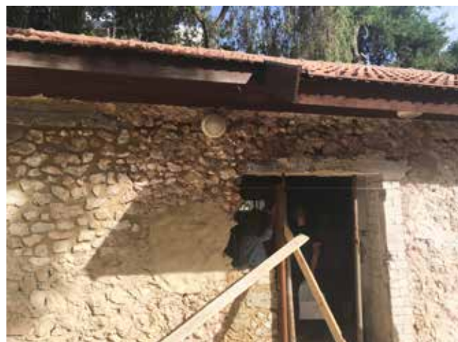
איור 9. עבודות שימור בבית הבאר. אדריכלי שימור: אמנון בר אור וטל גזית. צילום: יוסי לוי, 2017
